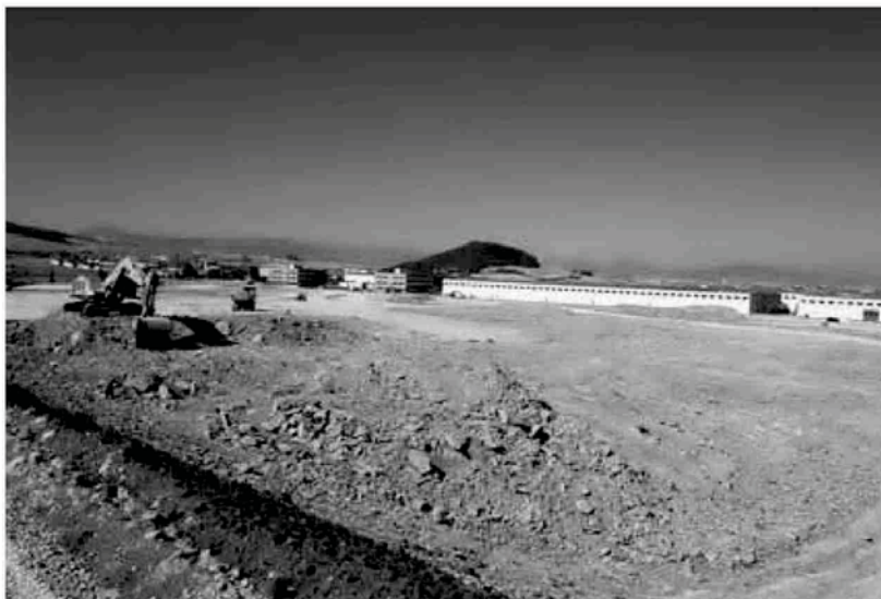
Aspecto que presentaban en octubre las obras de urbanización de los terrenos que ocupará la planta. CEDIDA
