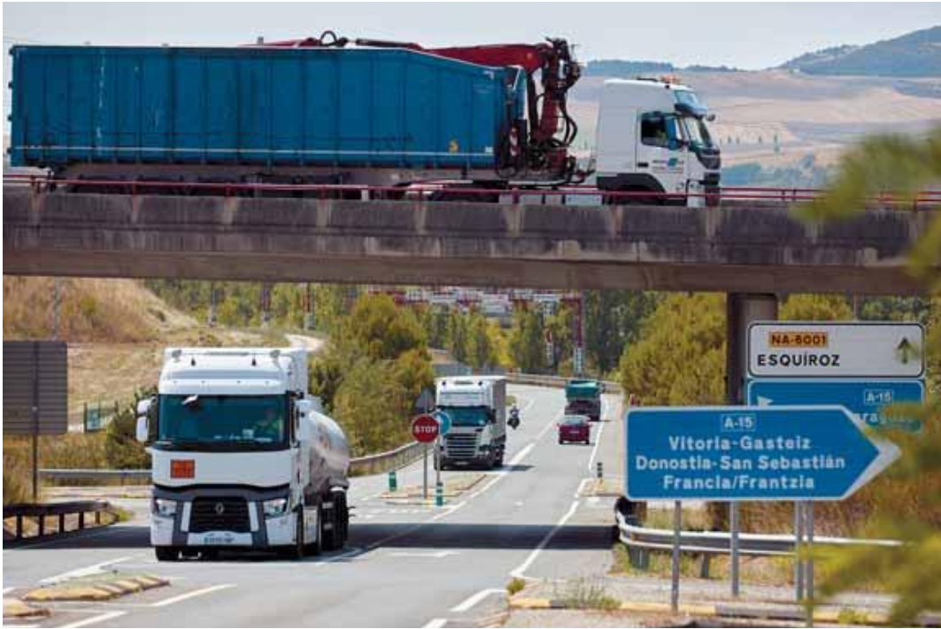
Enlace actual de la carretera de Esquiroz con la A-15. En ese punto confluyen vehículos pesados y ligeros. Allí se hará una rotonda. JESÚS GARZARON
